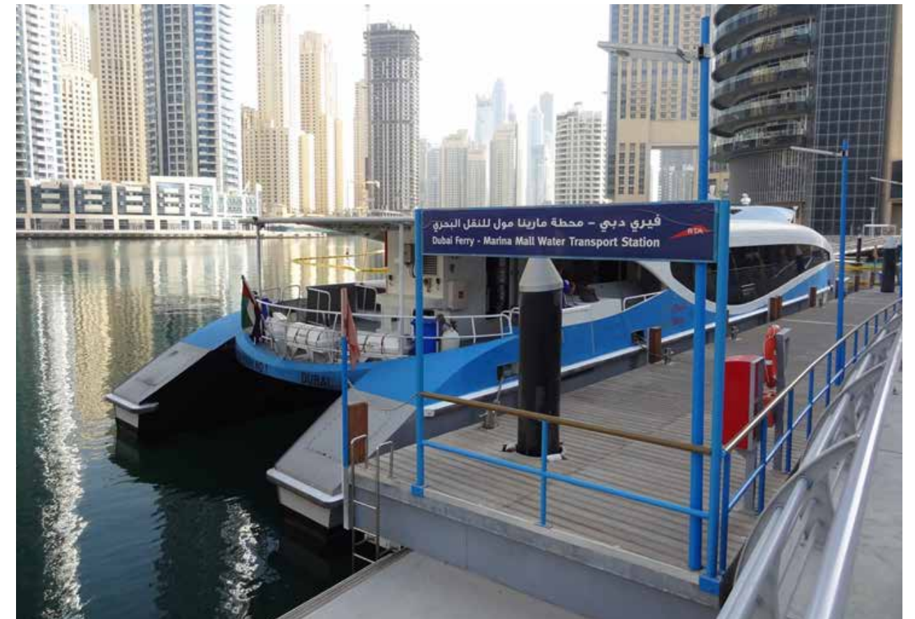
Anlegestation der Dubai Ferry in der Marina
